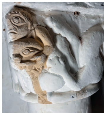
Un chapiteau en cours de rénovation
